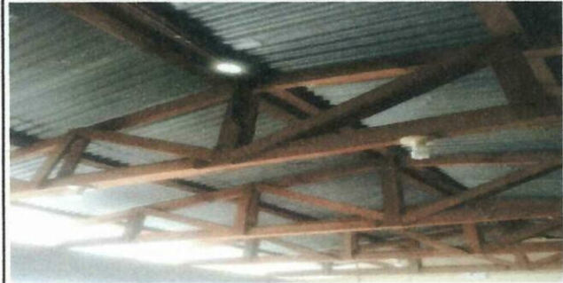
Foto 2: Se cambiara estructura de madera a metal.
